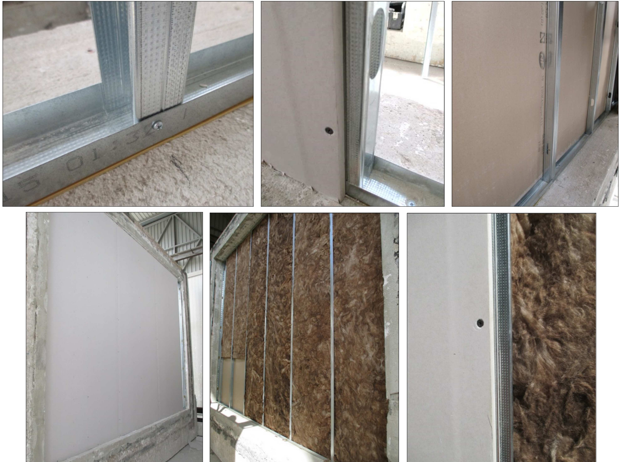
Imágenes 15 a 20 Construcción de la muestra
