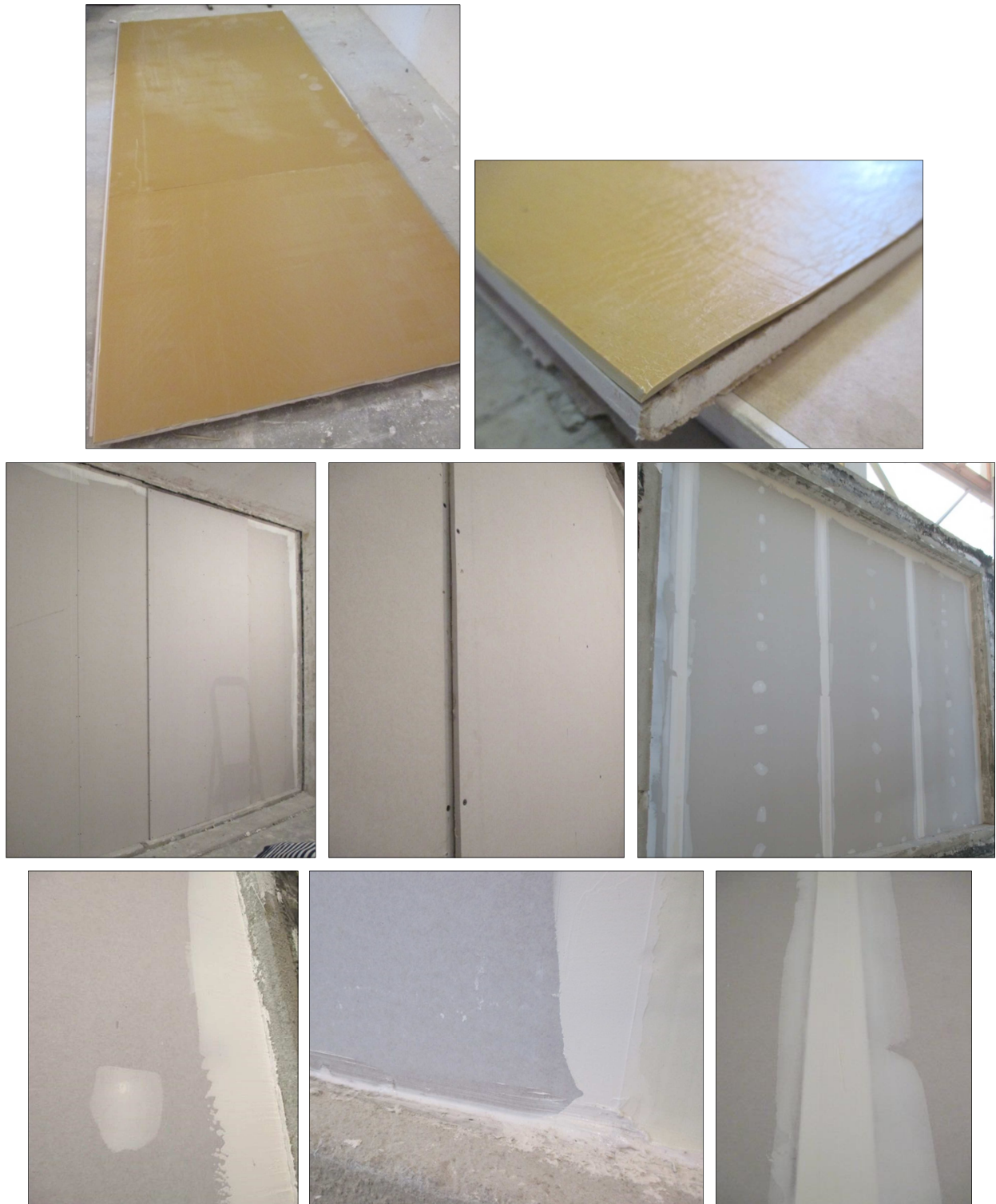
Imágenes 21 a 28 Construcción de la muestra
